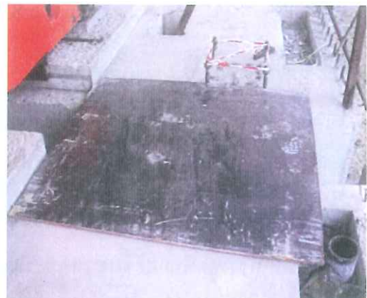
มีการนำแผ่นไม้มาปูเพื่อความ ปลอดภัย ป้องกันพนักงานเดินตกช่อง
