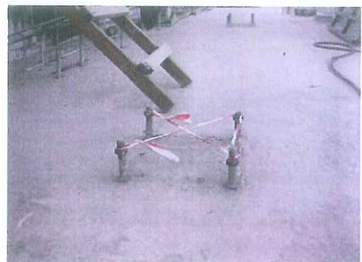
มีการนำเทปขาว-แดงมาผูกเป็น สัญลักษณ์ เพื่อเตือนพนักงานให้ระวังเดินสะดุดล้ม
