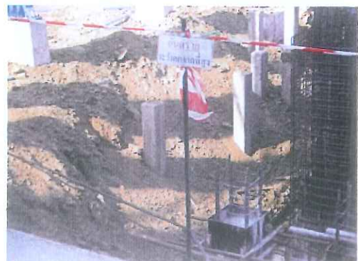
มีการนำเทปขาว-แดงมาผูกเป็น สัญลักษณ์ เพื่อเตือนพนักงานให้ระวังเดินสะดุดล้ม
