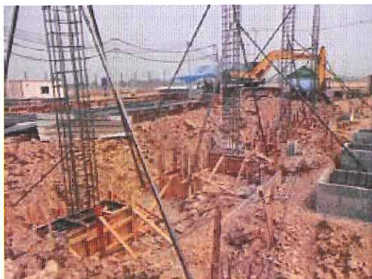
งานเสริมเหล็กเสาคอนกรีต
