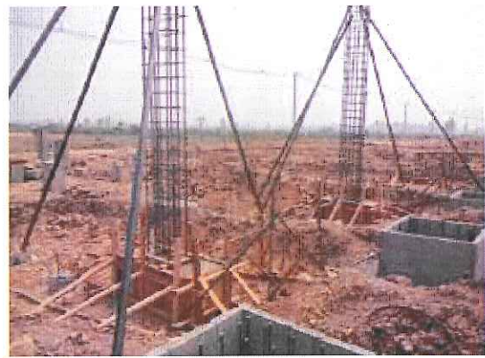
งานเสริมเหล็กเสาคอนกรีต
