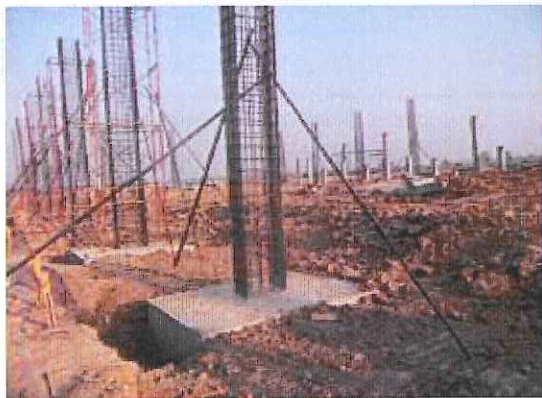
งานเสริมเหล็กเสาคอนกรีต
