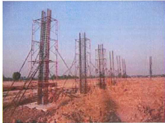
งานเสริมเหล็กเสาคอนกรีต
